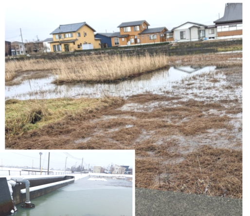
水底に泥がたまり雑草が生えて排水の悪い調整池
