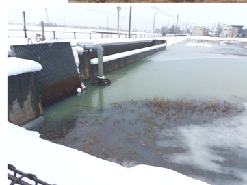
水底に泥がたまり雑草が生えて排水の悪い調整池
